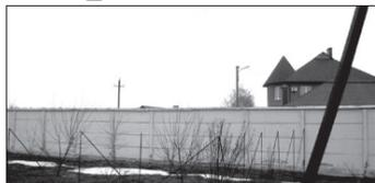
установлен на расстоянии всего трех метров от линии 6 кВ при норме в 10 метров, поэтому был высок риск электротравмирования персонала, занимавшегося складированием стройматериалов.
